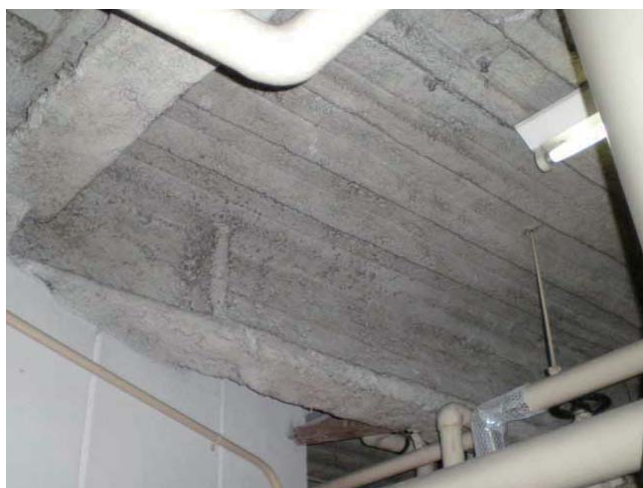
○エレベーター機械室天井・梁
