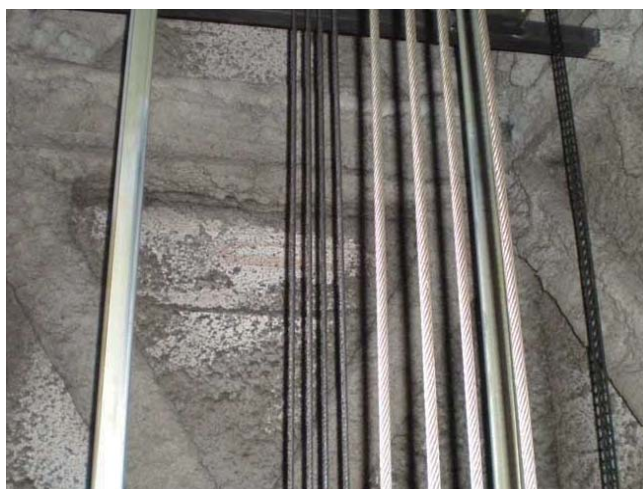
○エレベーターシャフト
