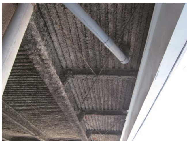
○駐車場天井・梁
