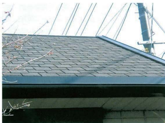
住宅屋根用平板石綿スレートの例
