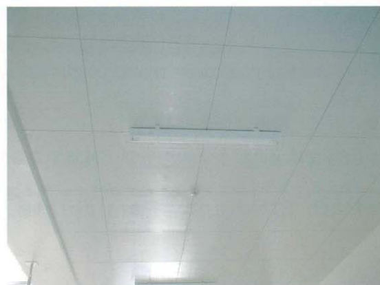
石綿含有けい酸カルシウム板石綿スレートの例 （石綿含有フレキシブルボード）
